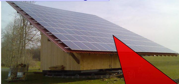
auf Dachfläche, aber keine bauliche Unterordnung
